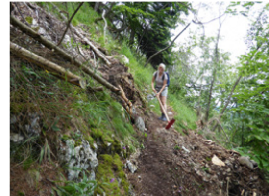
Nach der Beseitigung des Wurzelstocks wird der Weg hergerichtet © Matthias Pinkert
